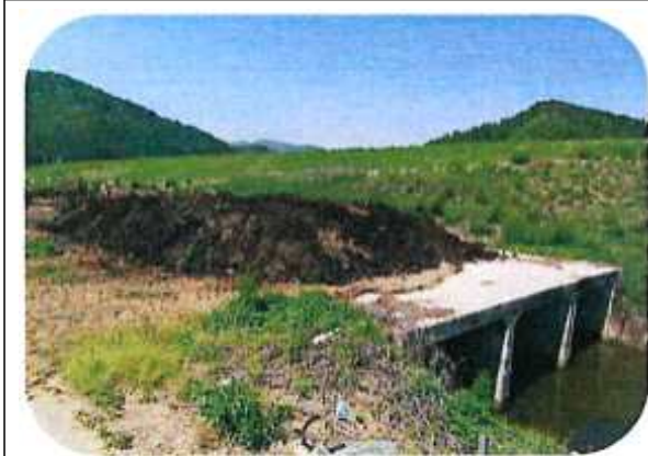
하천 주변 장소 야적, 비가림시설 미설치
