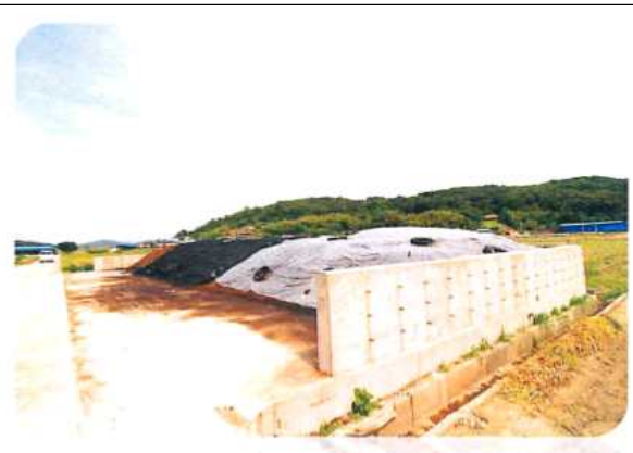
유출 방지턱 설치
