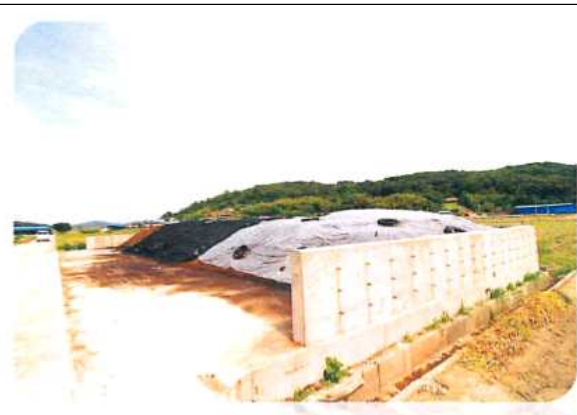
유출 방지턱 설치
