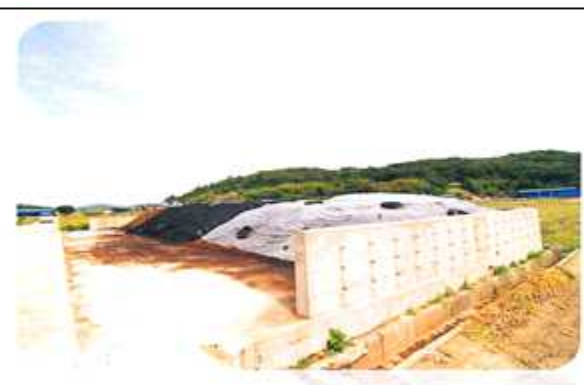
유출 방지턱 설치
